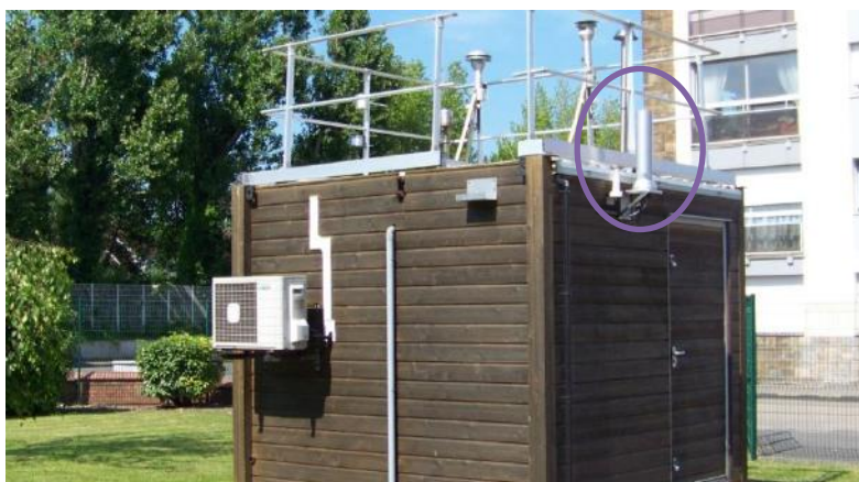
Station de mesure de Malo-les-Bains © Atmo Hauts-de-France
