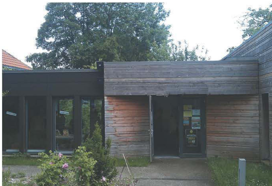
Un immeuble de bureaux investigué pendant l'étude
