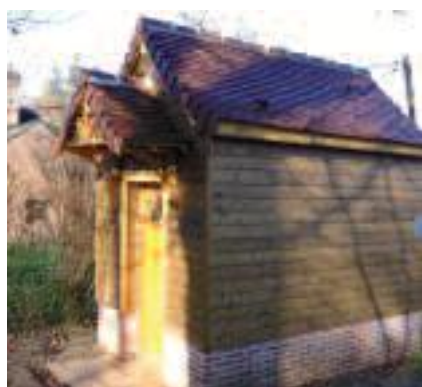
Nouvelle station de Crécy en Ponthieu
