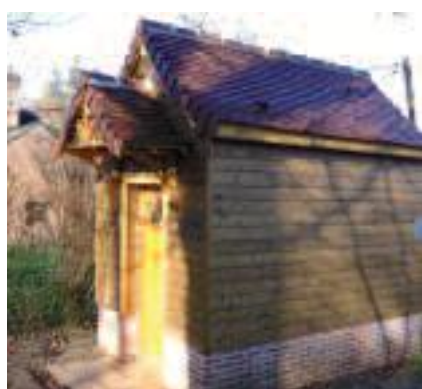
Nouvelle station de Crécy en Ponthieu
