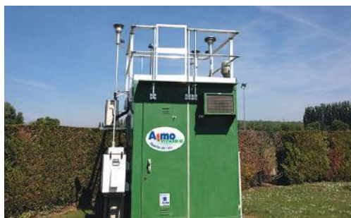
Station périurbaine de Nogent sur Oise
