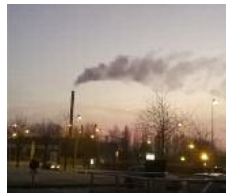
Dispersion horizontale de fumée d'usine
