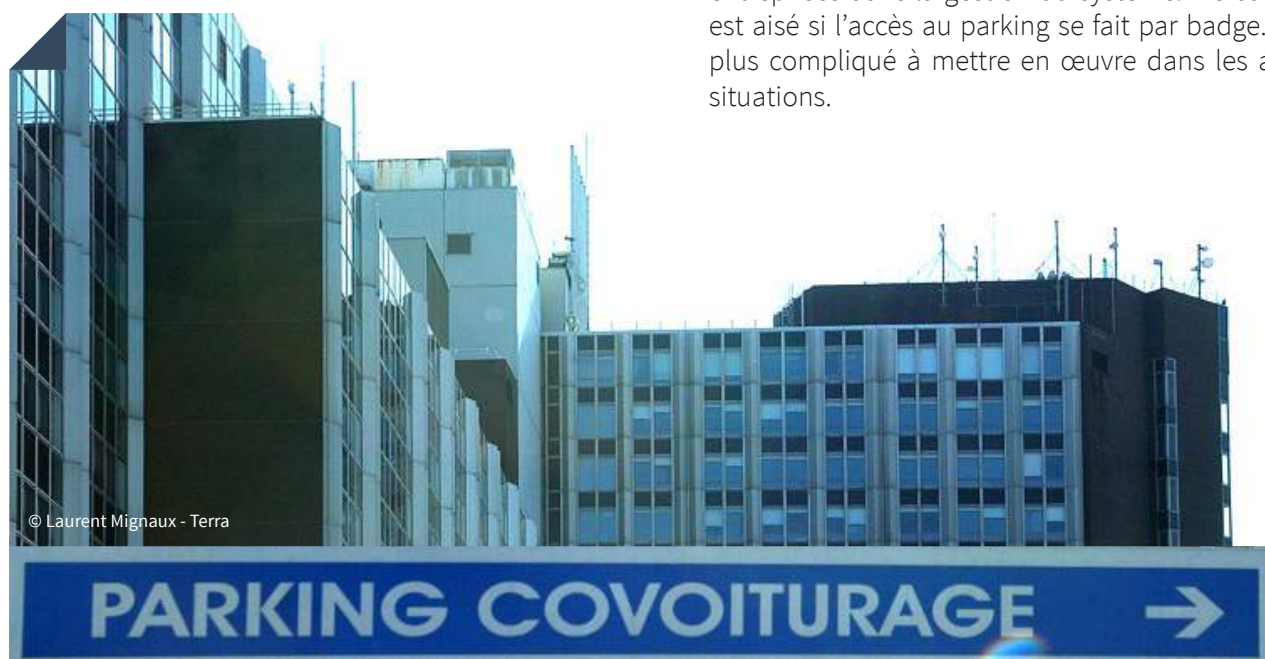
Figure 41 : Parking de covoiturage créé sur le parking de l'institut Gustave Roussy à Villejuif
