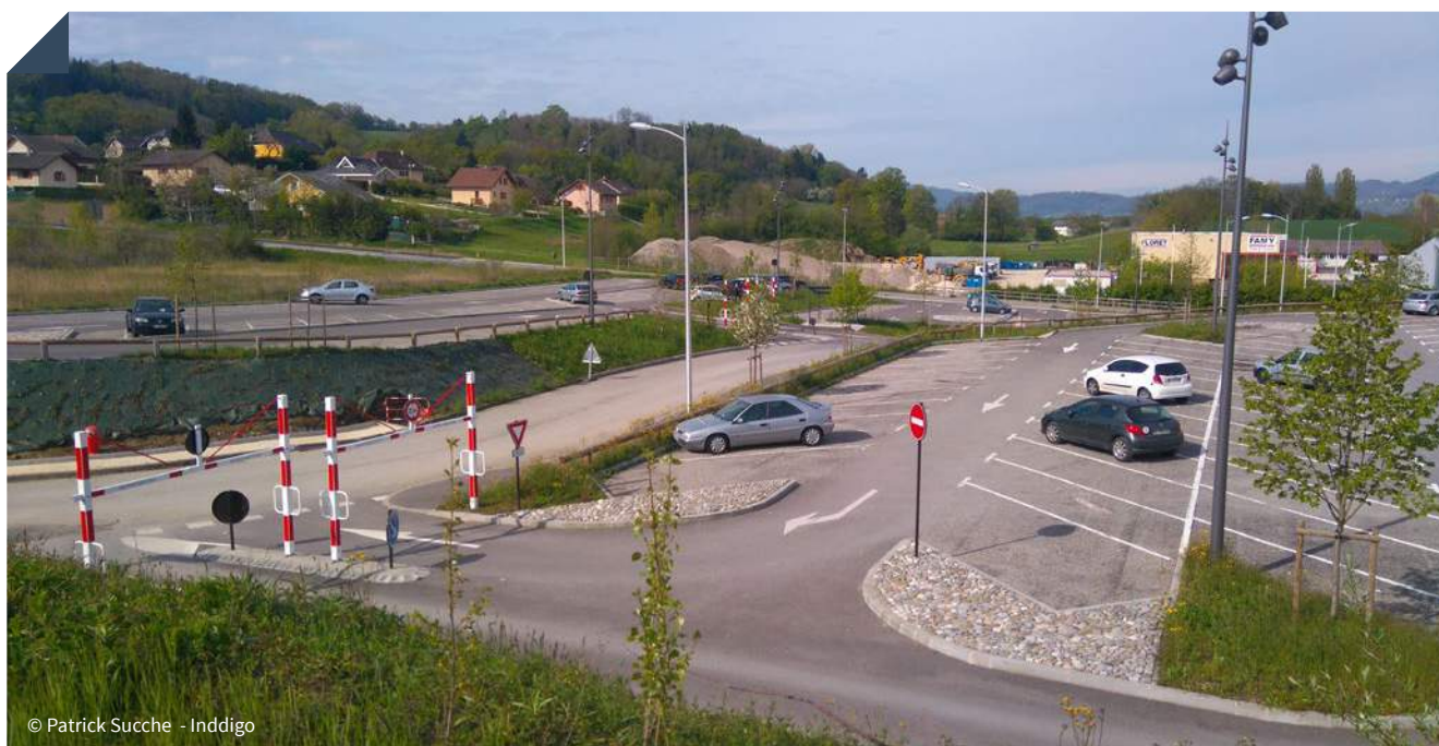
Figure 30 : Vue d'ensemble de l'aire de covoiturage d'Alby-sur-Chéran-74 (90 places)
