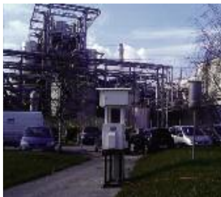
Préleveur installé dans l'enceinte de l'usine
