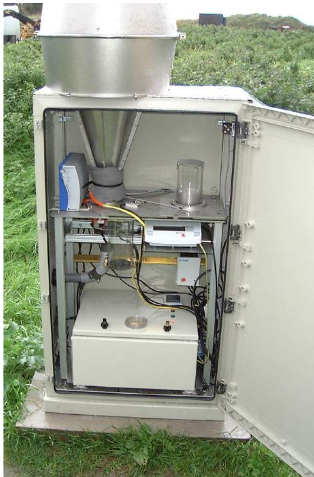
Figure 2 : Préleveur ADA MASS de Fort-Mardyck
