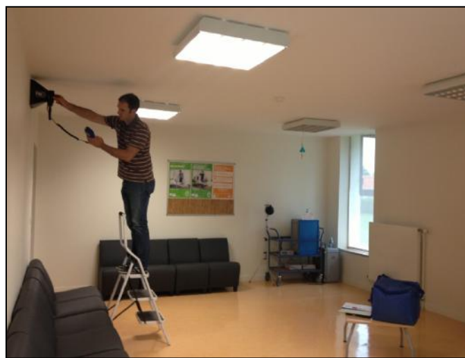
Figure 1 : Mesures des débits de ventilation (Internat de Ham)
