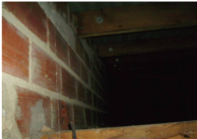
Mur séparant les combles des deux parties (années 1970 et 2003)
