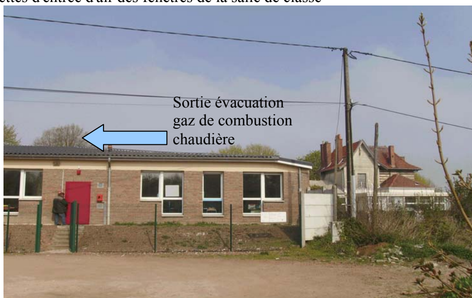
Proximité sortie chaudière et fenêtres salle de classe
