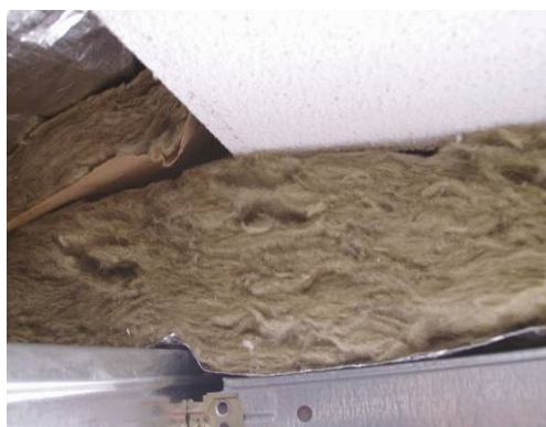
Comble au-dessus chaufferie et salle de classe ; isolant des combles
