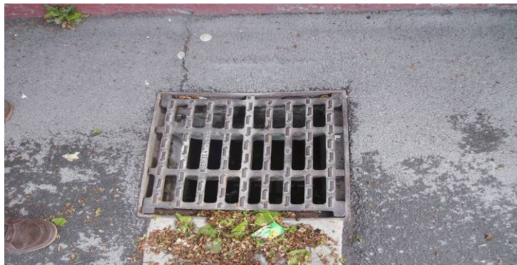
Avaloir eaux pluviales au pied des fenêtres salle 14
