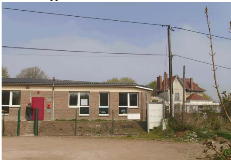
Remblai sous bâtiment
