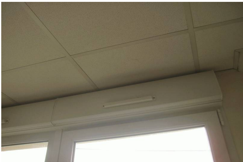
Réglettes d'entrée d'air
