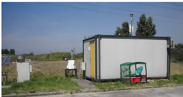
Stations de Fort-Mardyck (ci-dessus) et de Dunkerque (ci-contre)
