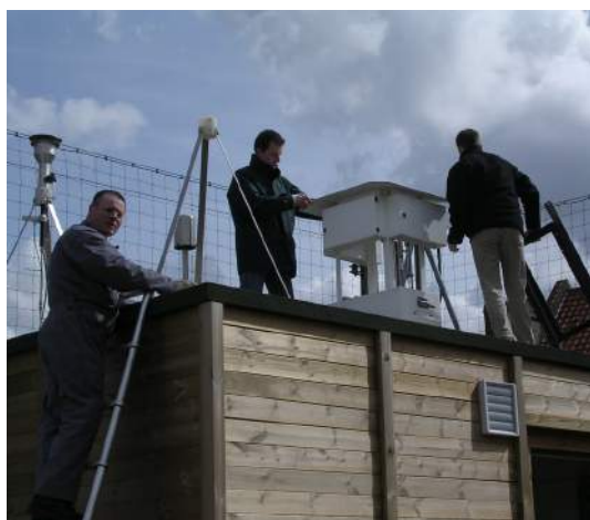
Installation du préleveur sur la station de Saint-Omer
