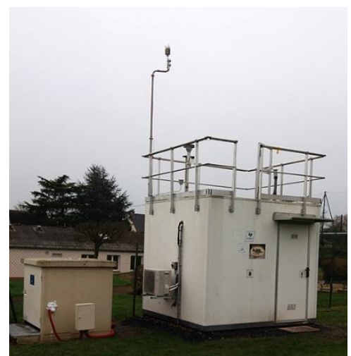
Station de mesures installée à Caillouël-Crépigny
