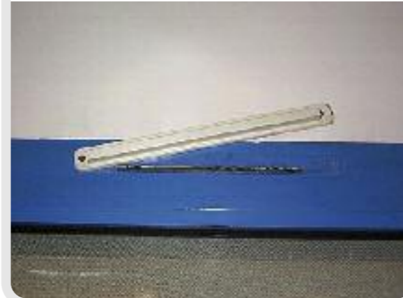
Photo 7 : Entrée d'air avec réservation trop étroite
