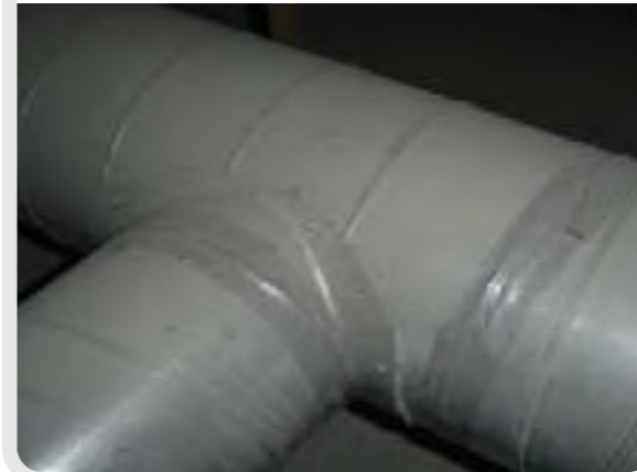
Photo 5 : Conduits étanches en combles
