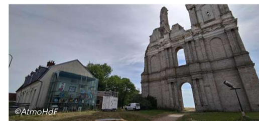
Site au centre du village - Place Hamilton à Mont St Eloi
